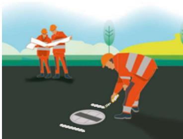
**Tracé au sol des points d'arrêt machine par le conducteur**
