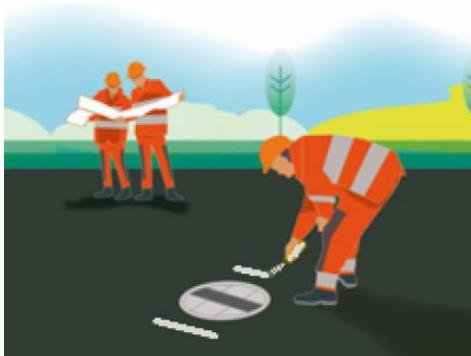
**Tracé au sol des points d'arrêt machine par le conducteur**
